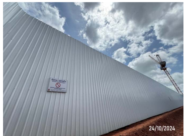
รูปที่ 2-4 แนวรั้ว Metal Sheet รอบแนวเขตพื้นที่โครงการ
