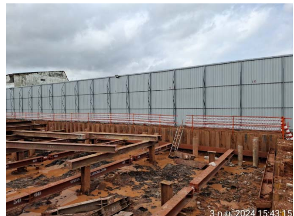
รูปที่ 2-7 แนวผนังกันดิน (Sheet pile) และตัวค้ำยัน (Bracing)
