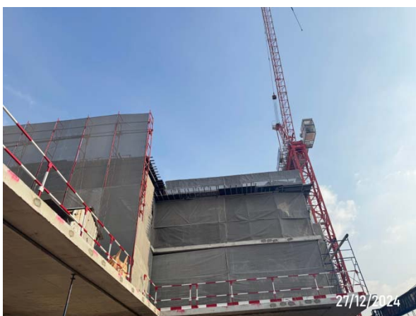
รูปที่ 2-10 ติดตั้งผ้าใบกันฝุ่น (Mesh Sheet)
