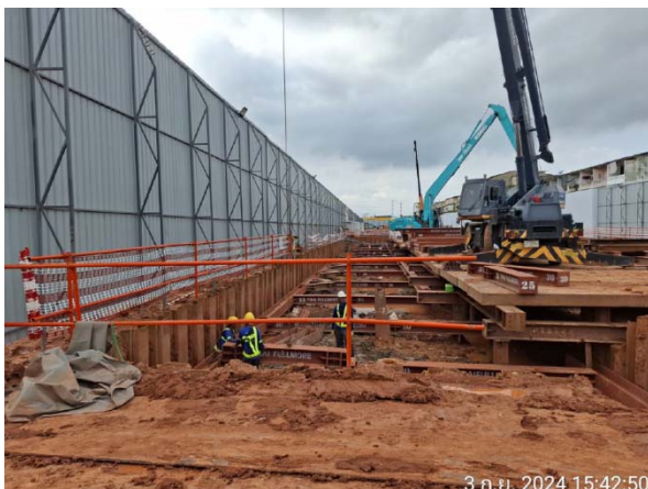
รูปที่ 2-7 แนวผนังกันดิน (Sheet pile) และตัวค้ำยัน (Bracing)
