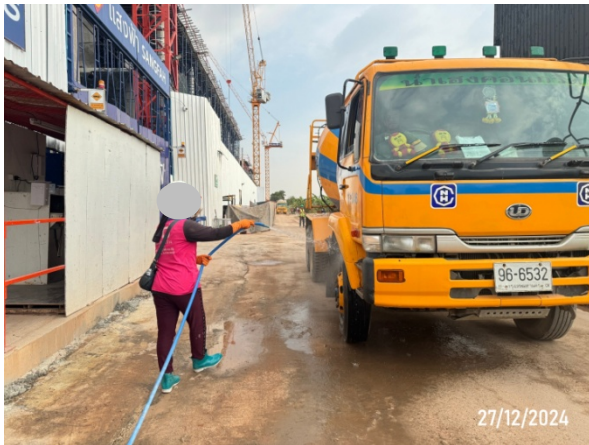
รูปที่ 2-12 เจ้าหน้าที่ทำความสะอาดล้อรถบรรทุก
