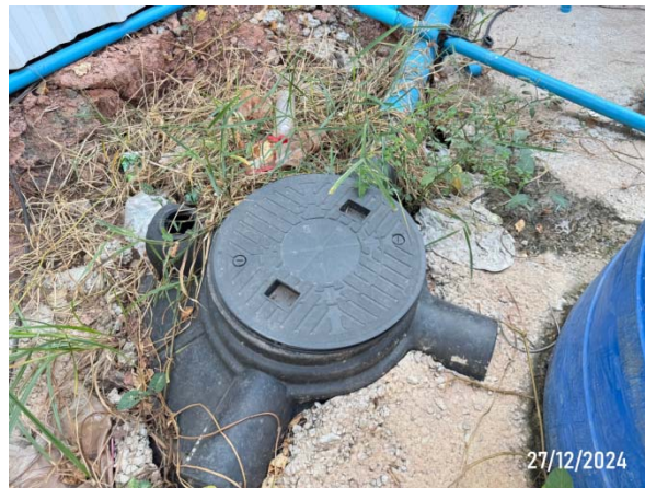
รูปที่ 2-21 ถังบำบัดน้ำเสียสำเร็จรูป
